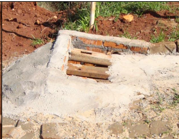
FOTO 02 – Infraestrutura de Drenagem
