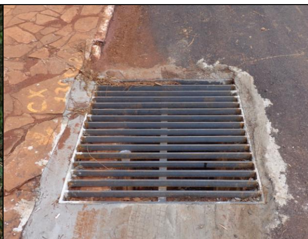
FOTO 04 – Boca de Lobo
