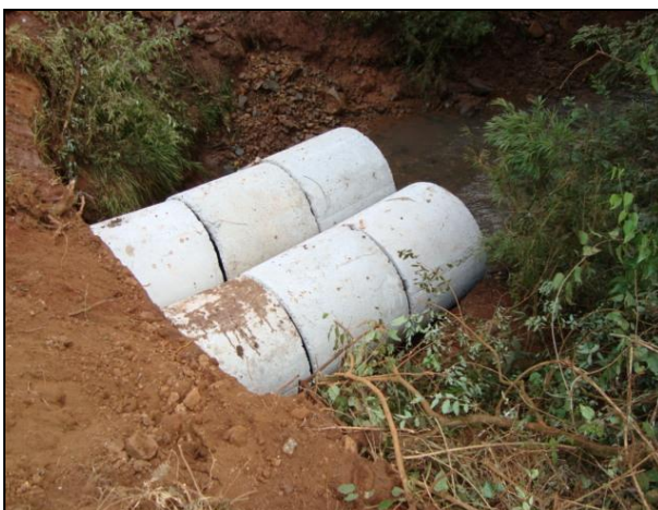
FOTO 03 – Infraestrutura de Drenagem
