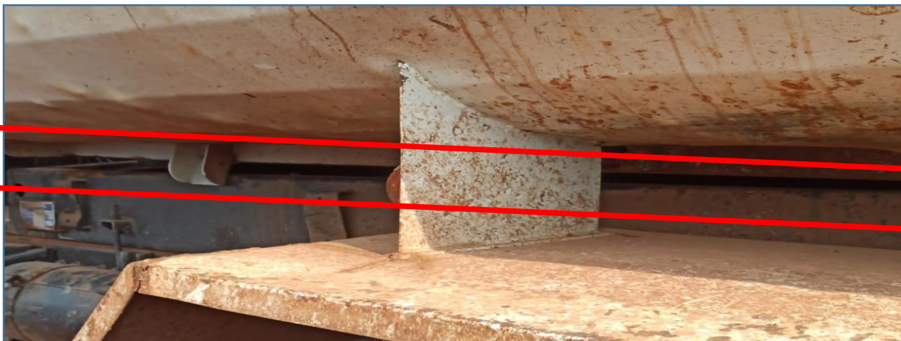
IMAGEM DA CAÇAMBA BASCULANTE E DO CHASSIS DO CAMINHÃO, PODEMOS VER CLARAMENTE COMO O MESMO FICOU TOTALMENTE DESALINHADO, COM UMA GRANDE ABERTURA ENTRE AMBOS. ESTE É O LADO ESQUERDO (LADO DO MOTORISTA)
